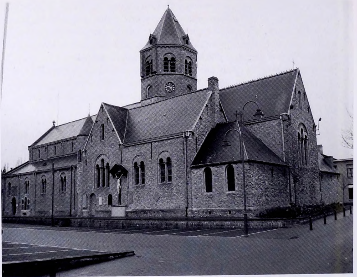
Het buitenvzicht van de H.Kruiskerk was na de restauratie van 1904 overwegend neo-romaans.
